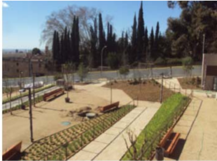
Acabado de la cubierta ajardinada
