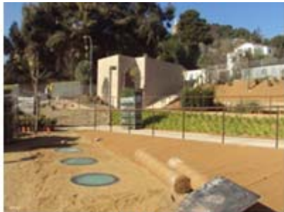
Imagen exterior de los lucernarios
