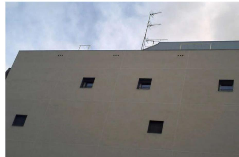
Obras de rehabilitación de la medianera de un edificio de la calle de Concepción Arenal. Obsérvese la presencia de agujeros de entrada para vencejos en la parte superior. Foto: Sergi García
