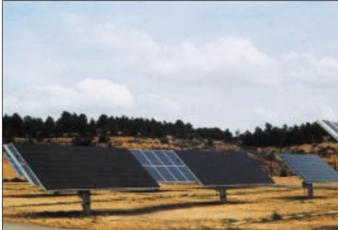
Físicamente, cada rama del generador está soportada por un único seguidor; y el conexionado de las ramas en paralelo hasta el inversor se lleva a cabo en dos cajas de conexión de campo. A cada una llegan los terminales de veinte ramas.
