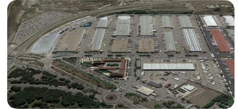
Puerto Seco y Centro de Transportes de Coslada
