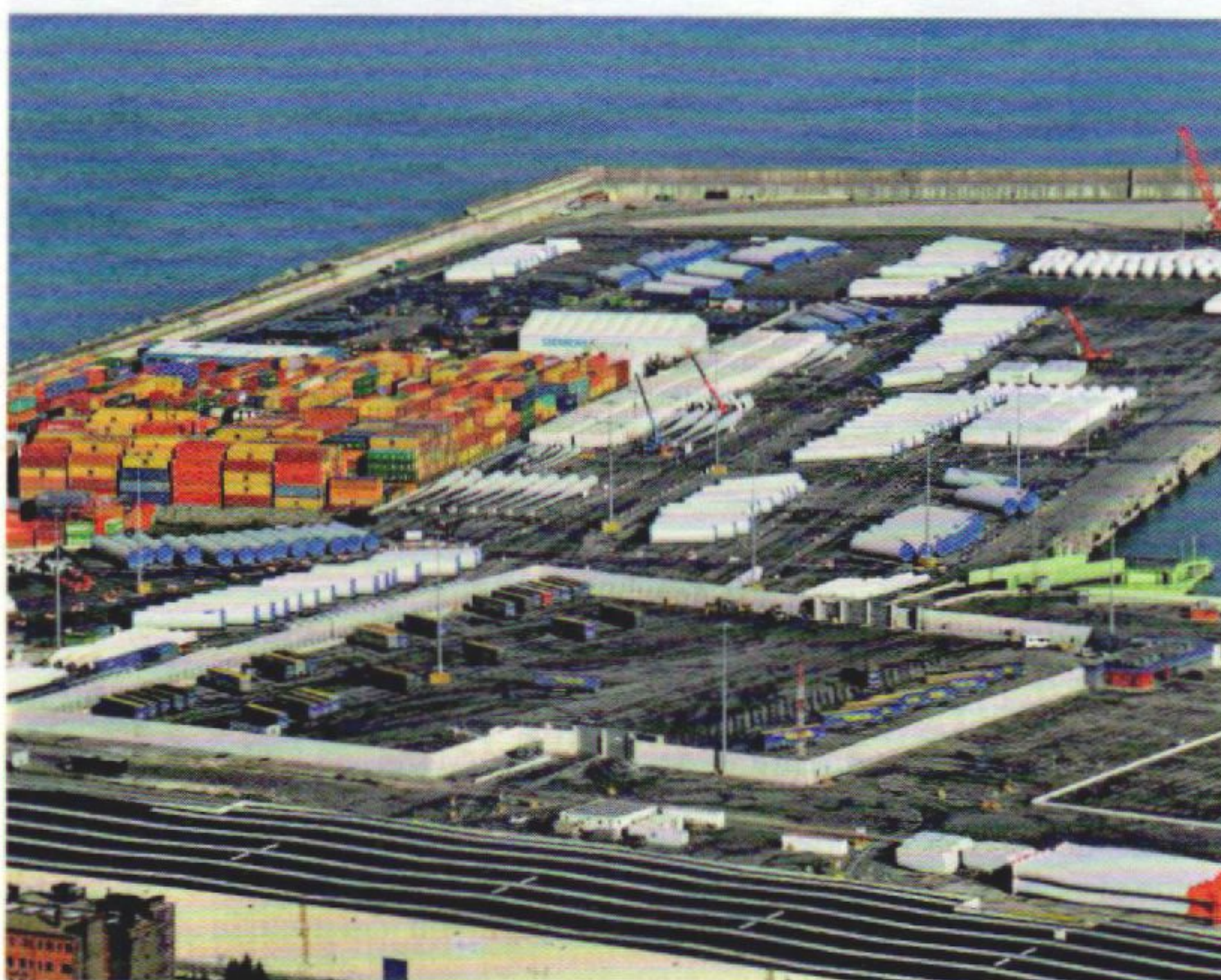
Vista aérea de las actuales instalaciones de la sociedad Plataforma Marítimo Multimodal.
