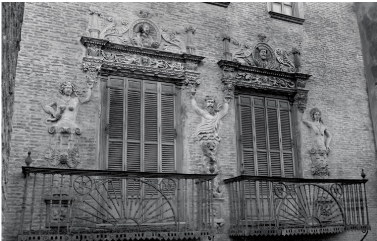
Relieves en la fachada del palacio del Almirante (s.XVII)
