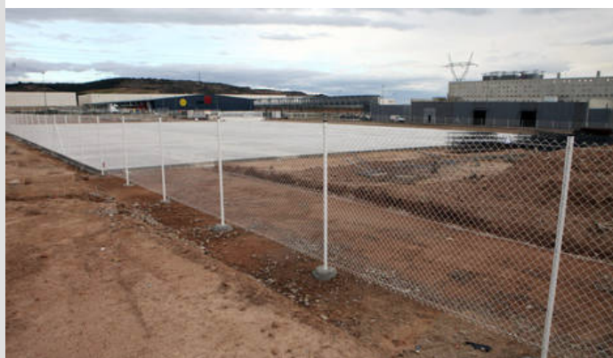
Imagen actual de la parcela del 'Puerto seco' en la CAT de Tudela. n.g. landa
